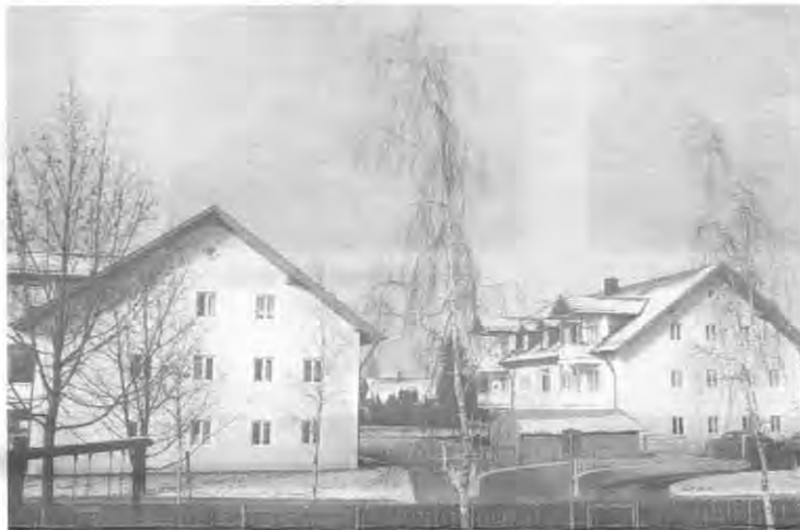
Die Sozialwohnungen der Kreiswohnungsbau GmbH in der Josef-Haydn-Straße in Pocking.
