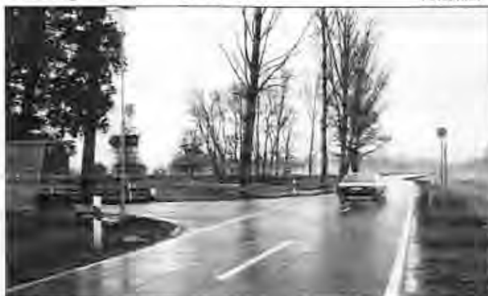
Durch die Entschärfung der Einmündung bei Niederindling wird die Verkehrssicherheit erhöht.
